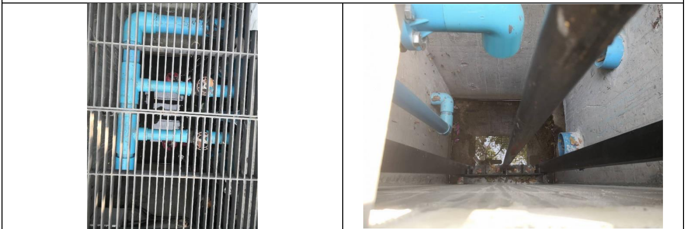
รูปภาพที่ 29 ตะแกรงดักขยะก่อนระบายน้ำออก
