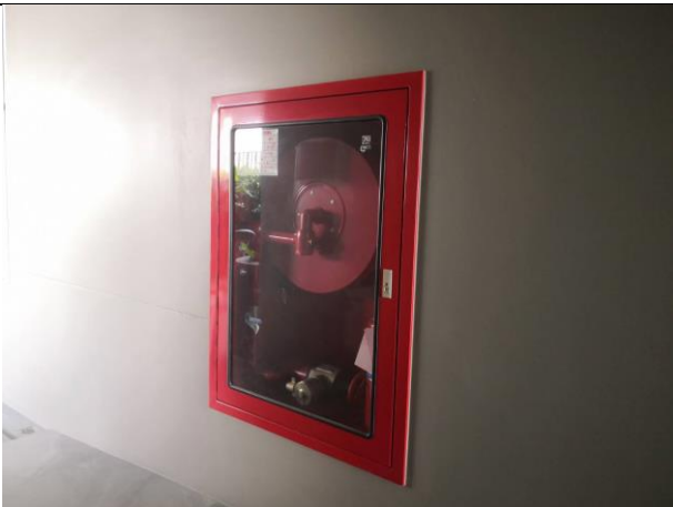
รูปภาพที่ 10 ตู้เก็บสายดับเพลิง
