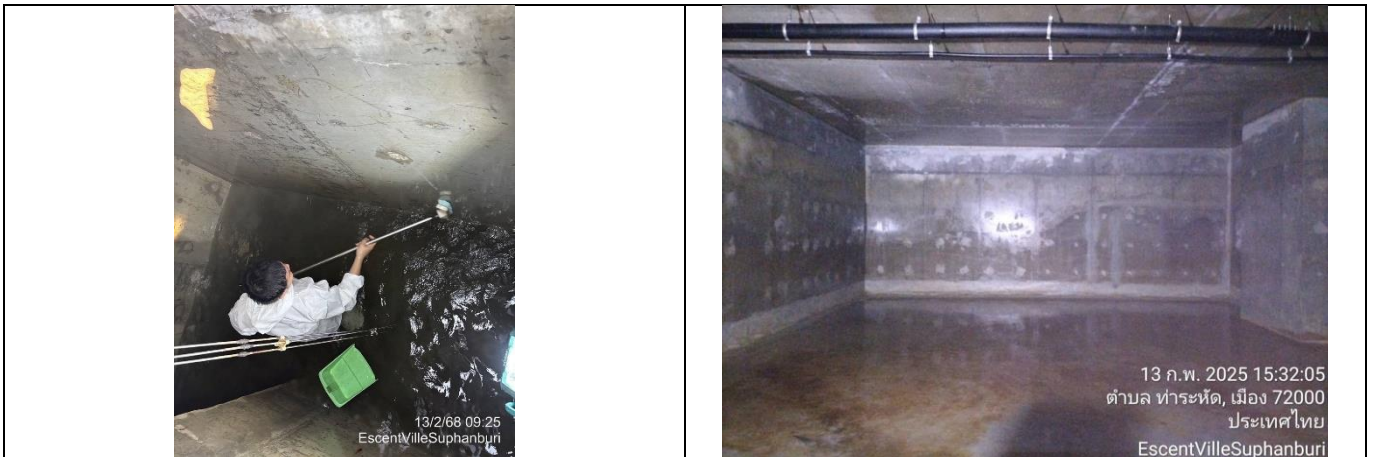
รูปภาพที่ 28 ล้างถังสำรองน้ำใต้ดิน/ชั้นดาดฟ้า
