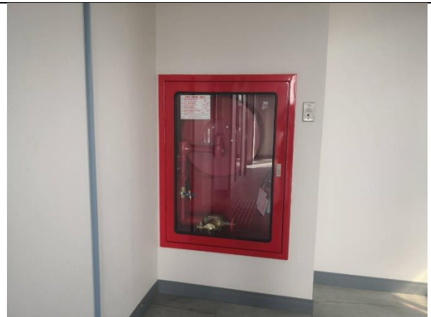
รูปภาพที่ 10 ตู้เก็บสายดับเพลิง
